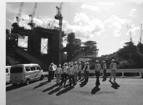
河内川橋工事
