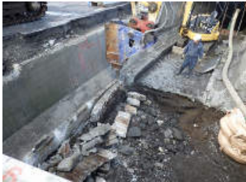
管渠設置箇所の既設水路取壊し
