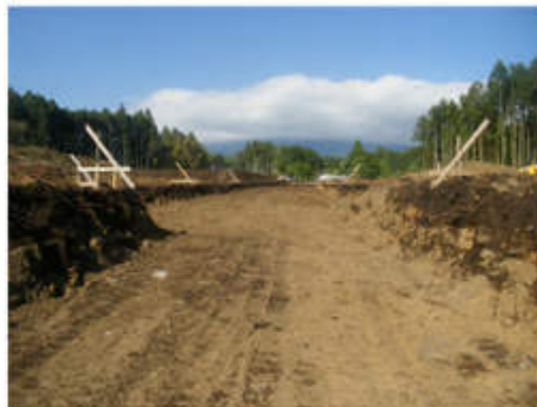
・ 仮設走路写真(南側から現場に向かう)
