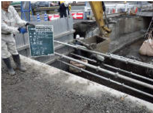
バックホウでの掘削と鋼矢板設置の並行作業
