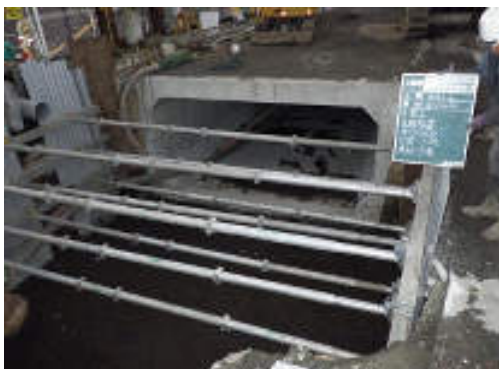
バックホウでの掘削と鋼矢板設置の並行作業
